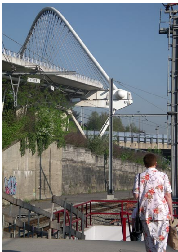
Mettre sur pied un projet adapté aux problèmes, aux ressources et aux opportunités relève de la capacité d'action collective et de l'articulation des acteurs mobilisés. Ici, la gare des Guillemins à Liège, citée comme exemple par J. Rémy. ■
