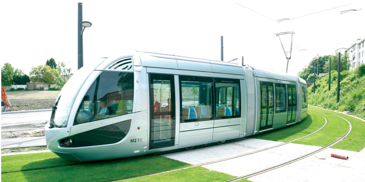
La ville de demain passe par le renouveau du transport collectif. A Valenciennes, le tramway a aussi permis de désenclaver des quartiers et des équipements qui n'étaient accessibles qu'en voiture ou ne bénéficiaient que d'une desserte symbolique. Photo : SITURV – Samuel Dhote
