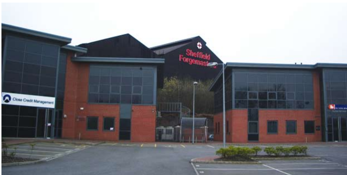
Développement de bureaux à proximité immédiate d'un site sidérurgique à Sheffield. Photo : P. Guilliams, Segefa-ULg
