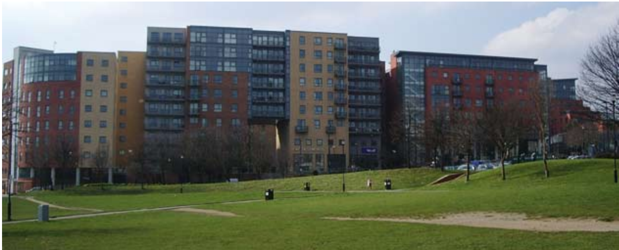
Développement résidentiel en milieu urbain en Angleterre. Immeuble à appartements à Sheffield. Photo : P. Williams, Segefa-ULg
