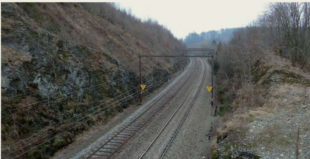
La ligne ferroviaire Namur – Luxembourg à Mellier (Léglise).
