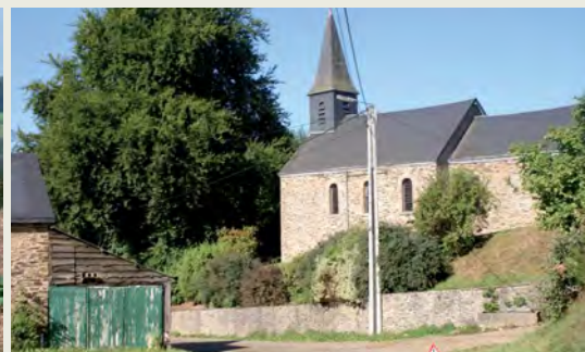
Le village de Mousny (La Roche-en-Ardenne) apparaît comme un hameau attrayant. Limité en contrebas par les méandres de l'Ourthe, il présente des constructions en moellons de schiste et de quartzite.
