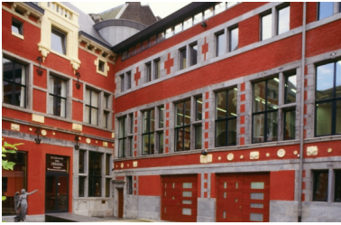
Après restauration, un ensemble avec commerce d'antiquité, atelier de restauration, logements et bureaux
