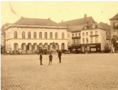
La cellule technique d'urbanisme promeut l'usage de matériaux traditionnels, comme l'enduit (Grand-Place d'Ath au début du XXe siècle)
