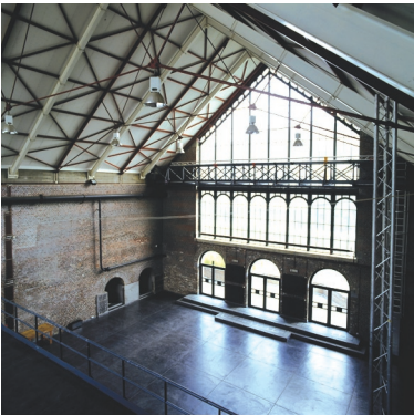
Donner à un cadre bâti un nouvel usage sans le déstructurer : ancienne machine à eau transformée en centre d'exposition et de spectacle (Mons)
