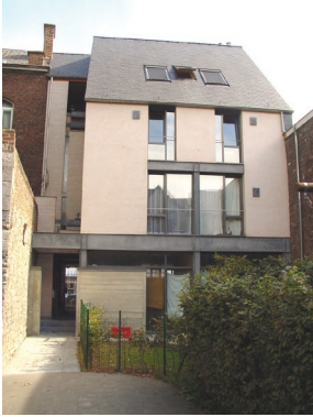
Intervention en comblement à proximité de l'ensemble de la rue Courtenay
