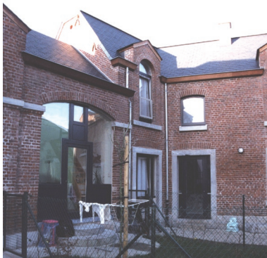
A l'initiative du Fonds du logement, trois nouveaux logements aménagés dans d'anciens ateliers de la SNCB. Coût total : 342.000 € (Salzines)
