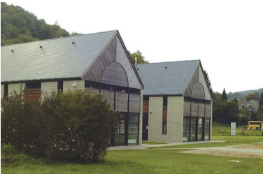
Construction d'une «mini-zone» en milieu rural, avec un souci d'intégration architecturale et paysagère
