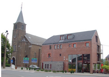
En plein centre de Wanze, une opération associant logements et activités commerciales
