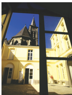
Tournai, ancien hôtel Crombez accueillant des logements sociaux
