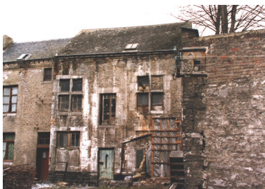
L'ensemble de la rue Courtenay au moment de son acquisition par le Fonds du logement
