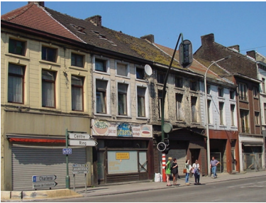
La cessation définitive d'activités commerciales de proximité participe à la dégradation de l'espace bâti
