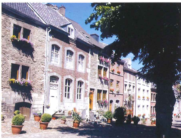
Deux vues courtes dans
