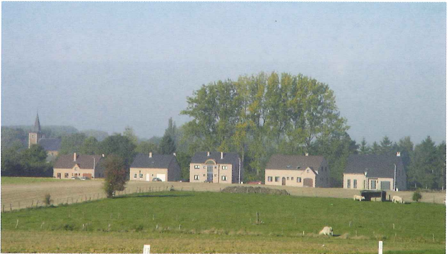
Bien que le plan de secteur ait empêché une urbanisation diffuse sur l'ensemble du territoire, il a conduit au développement de rubans bâtis déformant la structure traditionnelle de l'habitat rural. Eghezée.
