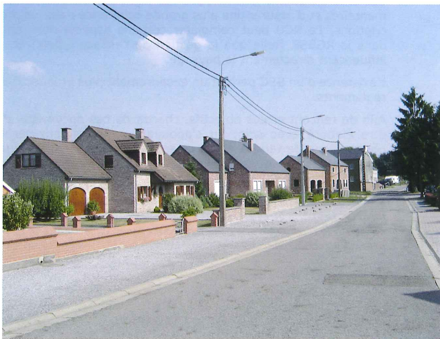
Différentes générations de bâtiments se succèdent le long de cette voirie à Amay. Le règlement communal d'urbanisme a permis d'adapter les choix des matériaux et les gabarits des bâtiments au contexte local. Ainsi, la hauteur imposée sous gouttière a été portée à 4m pour s'harmoniser au bâti traditionnel.
