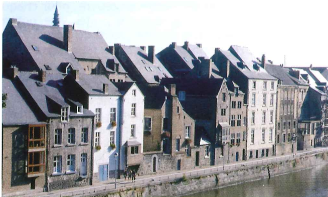
Ensemble formé par la Sambre et l'arrière des immeubles de la rue des Brasseurs à Namur. Au début de années '80, ce quartier a été l'objet d'une opération pilote de rénovation urbaine.
