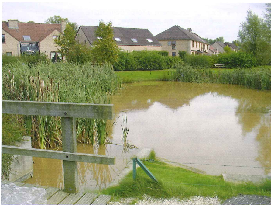
Cette zone d'aménagement différé a été mise en œuvre pour y installer un bassin d'orage. L'utilité technique de l'ouvrage va de pair avec la qualité esthétique de l'aménagement. Braine-l'Alleud.
