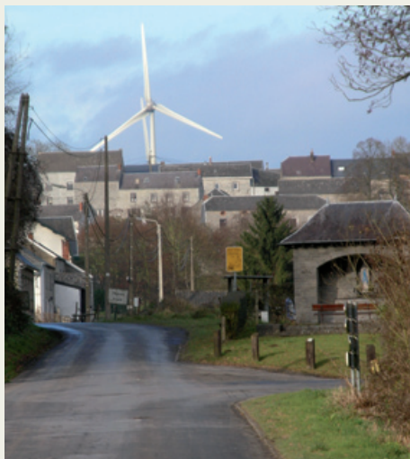
Vue sur Thynes qui paraît écrasé par les pales de l'éolienne implantée à six cents mètres du village.
