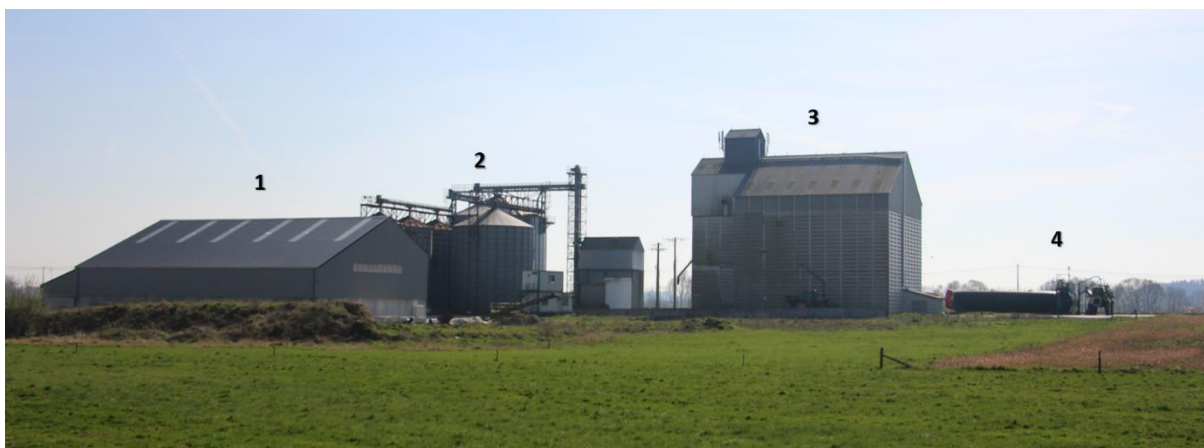
Figure 3. Site de stockage de céréales de la Société coopérative de la Meuse (SCAM) à Meux (La Bruyère). 1) Hangar horizontal pouvant servir au stockage à plat de matériel, d'engrais solides, de céréales ou d'autres denrées, 2) Silos verticaux cylindriques de taille différente avec leur tour de manutention et leurs bandes transporteuses, 3) Imposant silo vertical de type palplanche et 4) Cuves horizontales fournissant des produits phytosanitaires aux agriculteurs. Photo : D. Bruggeman (2017).
