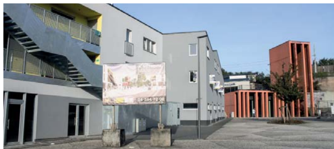
Photo : rénovation de la gare associée à la création d'une esplanade bordée de logements en centre-ville dans le cadre du Master Plan 'Coeur d'Herstal' © CPDT
