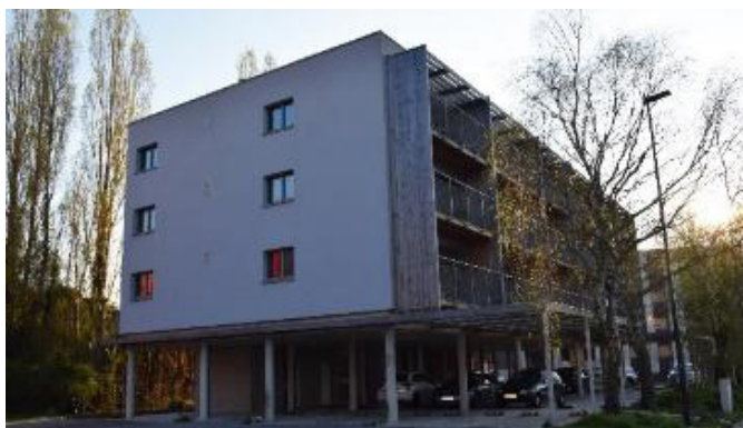
Ce bâtiment construit sur pilotis offre 12 logements adaptables. Cette configuration permet aux PMR de garer leur véhicule au plus près de leur logement et d'y accéder aisément via un ascenseur
