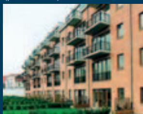
Appartements sur une ancienne friche industrielle à Koekelberg (photo SDRB).
