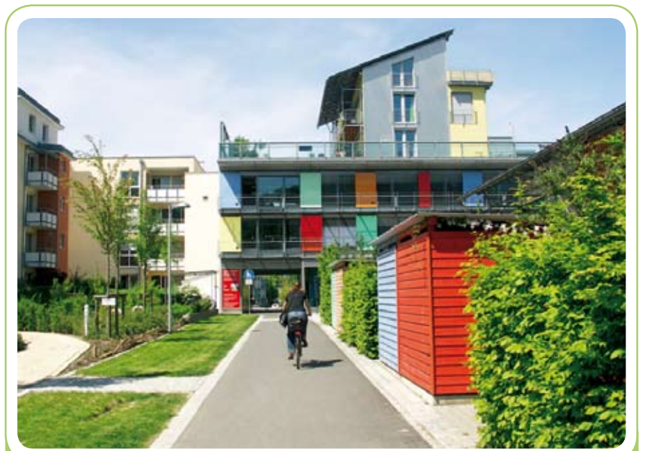
Un bon exemple de diversité fonctionnelle à Fribourg en Allemagne : un immeuble accueille un rez commercial, deux étages de bureaux et des habitations. Devant, des garages pour vélo et des locaux pour la gestion des déchets.
