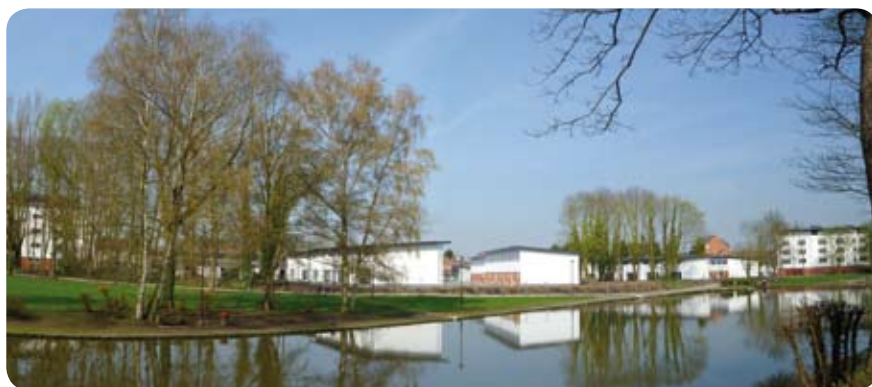
Le quartier de l'île aux oiseaux, à Mons : un projet d'écoquartier pionnier (Architecte A2M, maître de l'ouvrage Thomas et Piron – Toit et Moi).
