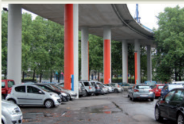
Les piliers du ring derrière la gare de Charleroi.
