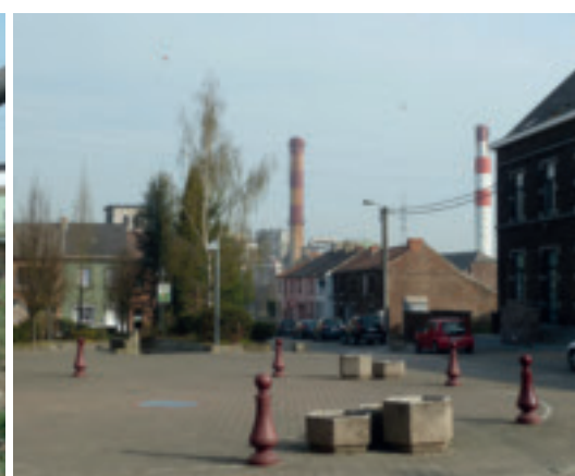
Quelques noyaux habités sont visuellement dominés par les infrastructures industrielles. A gauche, un alignement de maisons ouvrières, implanté entre une voie ferrée et les hauts bâtiments d'un complexe sidérurgique, semble « écrasé » par l'imposant gazoduc aérien qui le surplombe (Marchienne-au-Pont). A droite, l'incinérateur bordant la Sambre compose l'arrière-plan de l'ancien noyau villageois de Pont-de-Loup (Farciennes).
