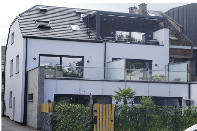
Herve. La division et l'extension de cette maison offrent à chaque logement un espace privé extérieur appropriable (terrasse ou jardin).
