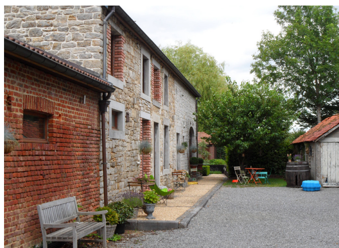
Gesves. Reconversion d'un ancien corps de ferme en logements autour d'une cour commune.
