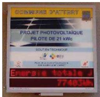
Le panneau d'affichage : Celui-ci est placé sur la façade de l'école et indique plusieurs informations en temps réel, à savoir : l'ensoleillement, la température des panneaux, la puissance électrique des panneaux, l'énergie électrique totale produite le jour en cours, l'énergie électrique totale produite depuis le démarrage de l'installation et les kg de CO<sub>2</sub> préservés depuis le démarrage de l'installation.
