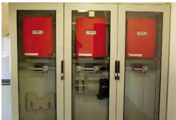
Trois onduleurs permettent de transformer le courant continu en courant alternatif
