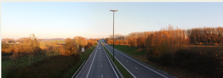
L'autoroute A8, éligible à l'Objectif 1 compte tenu de son statut d'axe transeuropéen, a bénéficié des fonds européens pour son achèvement (ici à Moustier, Frasnes-lez-Anvaing). Elle a mobilisé la part la plus importante du budget alloué à la réalisation de travaux d'infrastructures durant la période 1994-1999.
