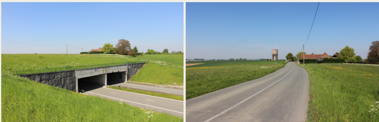
L'autoroute A8 traverse le tunnel du Chêne Saint-Pierre (à gauche), entre Bouvignies et Ostiches (Ath). Bien que plus coûteux qu'une simple excavation, l'ouvrage préserve un cadre visuel rural (à droite) lors du passage au-dessus de cet axe autoroutier.
