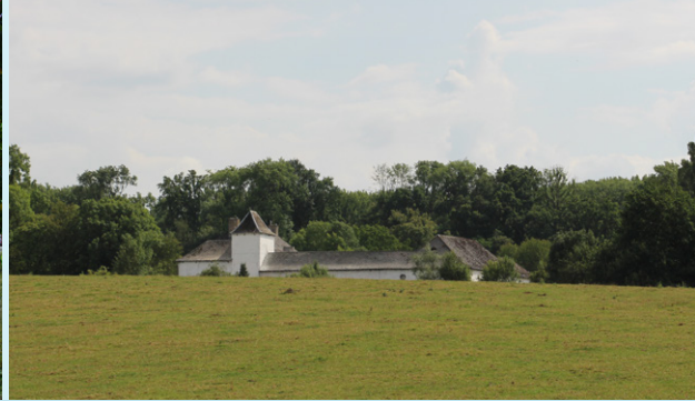
Le château de plaisance de Salmonsart (18 e siècle), entre Soignies et Braine-le-Comte, se développe selon un plan en « U ». La grosse ferme en quadrilatère, accolée sur la droite du château, forme avec celui-ci une unité de groupement particulièrement lisible et cohérente.
