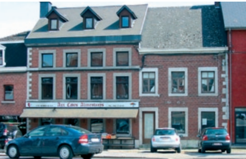
Die traditionellen Wohnhäuser (aus dem 17. und vor allem 18. Jahrhundert) sind aus Backstein mit Einfassungen aus Kalkstein um die Türen und Fenster. Zu dieser Zeit, als man andernorts mit Stein baute, war die Verwendung von Backstein ein Zeichen für die wirtschaftliche Entwicklung der Region, die mit dem Anlegen der Heckenlandschaft und der Milchwirtschaft (Soumagne) verbunden ist.
