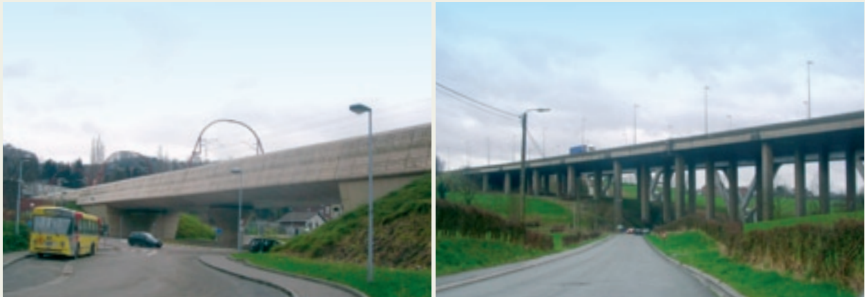
Die Überquerung des Tals in Vaux-sous-Chèvremont (Foto links) zeigt deutlich den Stempel des TGV in der nahen Landschaft. Ebenso wie das Doppelviadukt von Herve, dass der Stadt eine erhebliche Beschränkung hinsichtlich der Stadtgrenzen auferlegt (Foto rechts, mit der Talbrücke der Autobahn vor der Talbrücke des TGV im Hintergrund).
