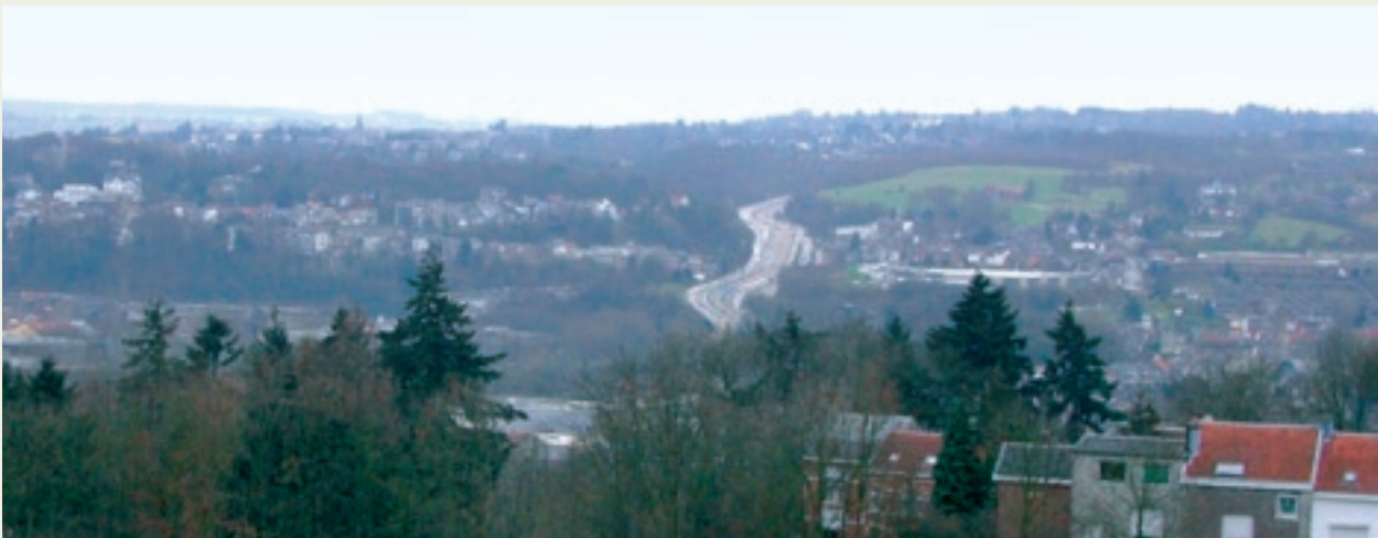
Die Autobahn im Süden von Verviers, Blick von Lambermont aus.
