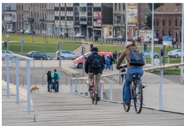
Liège - Passerelle cyclo-piétonne
