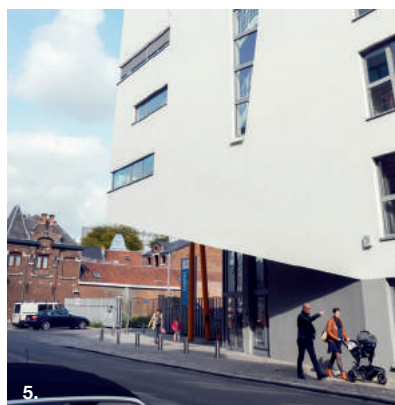
5. Verviers - L'aménagement de l'espace public rend clair et lisible l'accès à cet équipement (2018).
