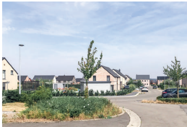
Namur - Lotissement à Erpent : tissu caractéristique des dernières extensions des villes et des bourgs en bâti discontinu (2018).
