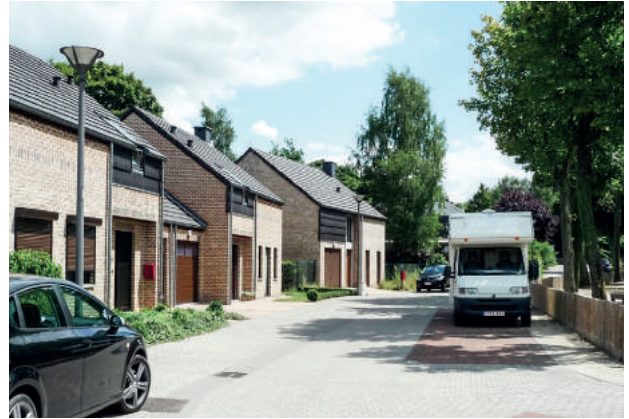
Arquennes - Stationnement suggéré sur le domaine de la voirie permettant une flexibilité des usages et une réversibilité aisée (2009).
