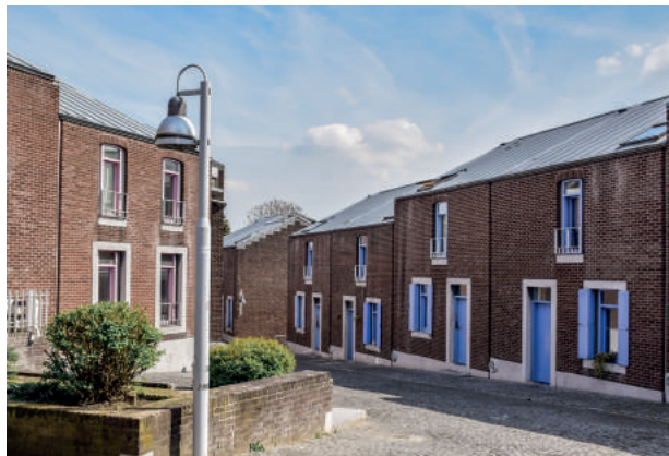
Liège - Cité Bernalemont. Urbanisation caractéristique des ensembles bâtis homogènes (2019).
