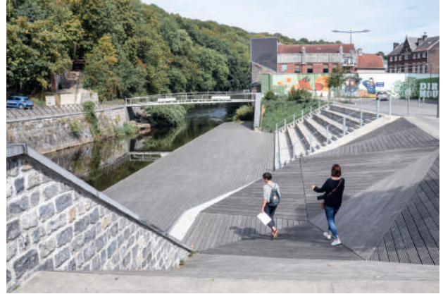
Verviers, cour Fischer - Le relief de la berge est exploité en agora et espaces ludiques (2018).
