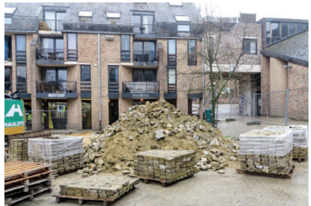
Louvain-la-Neuve - Récupération de pavés lors du chantier de réaménagement de la place des Wallons (2019).
