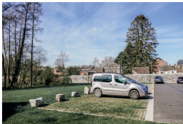
Fosses-la-Ville - L'emploi de dalles alvéolées optimise l'infiltration des eaux pluviales (2019).
