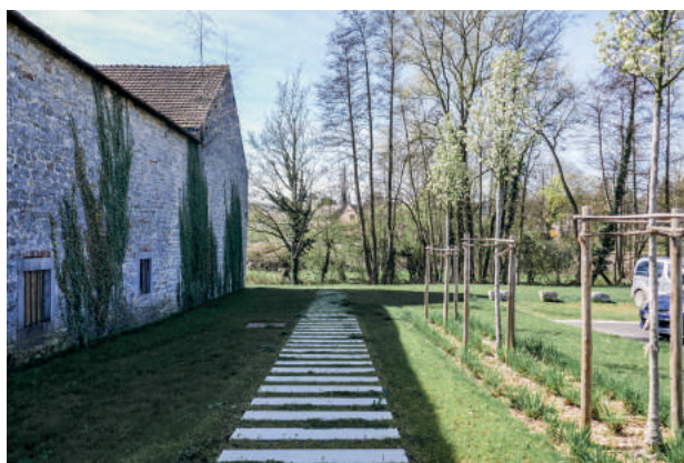
Fosses-la-Ville - L'aménagement limite l'imperméabilité du sol (2019).
