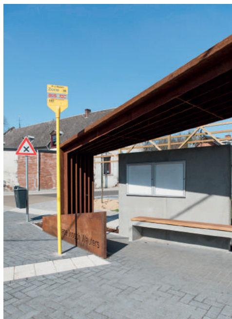
Oleye - Arrêt de bus dessiné pour l'espace public du centre du village, dans le cadre d'un PCDR et en concertation avec la TEC (2019).
