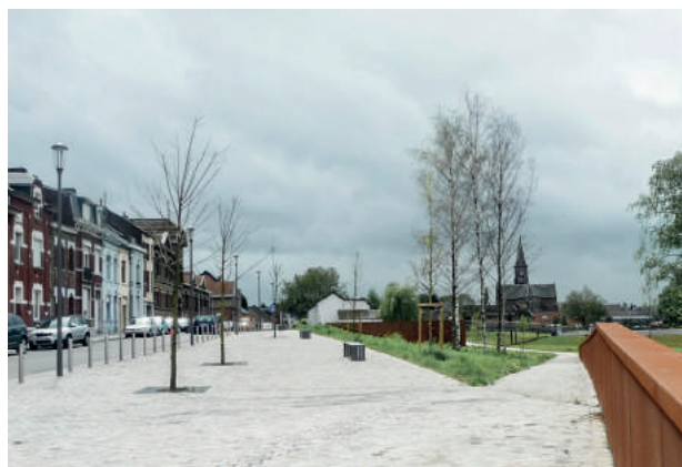
Ans - L'aménagement de la rue Monfort et ses abords a permis de renforcer le réseau d'espaces publics et d'offrir des espaces de séjour (2013).
