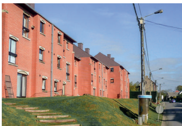
Lobbes - rue Paschal. La transition entre l'espace public et privé est ici gérée via un recul et la topographie (2012).
