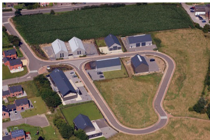
Vue aérienne de l'îlot d'entreprises (Olne)
