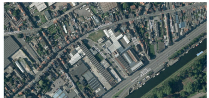
Vue aérienne du site Pieper
