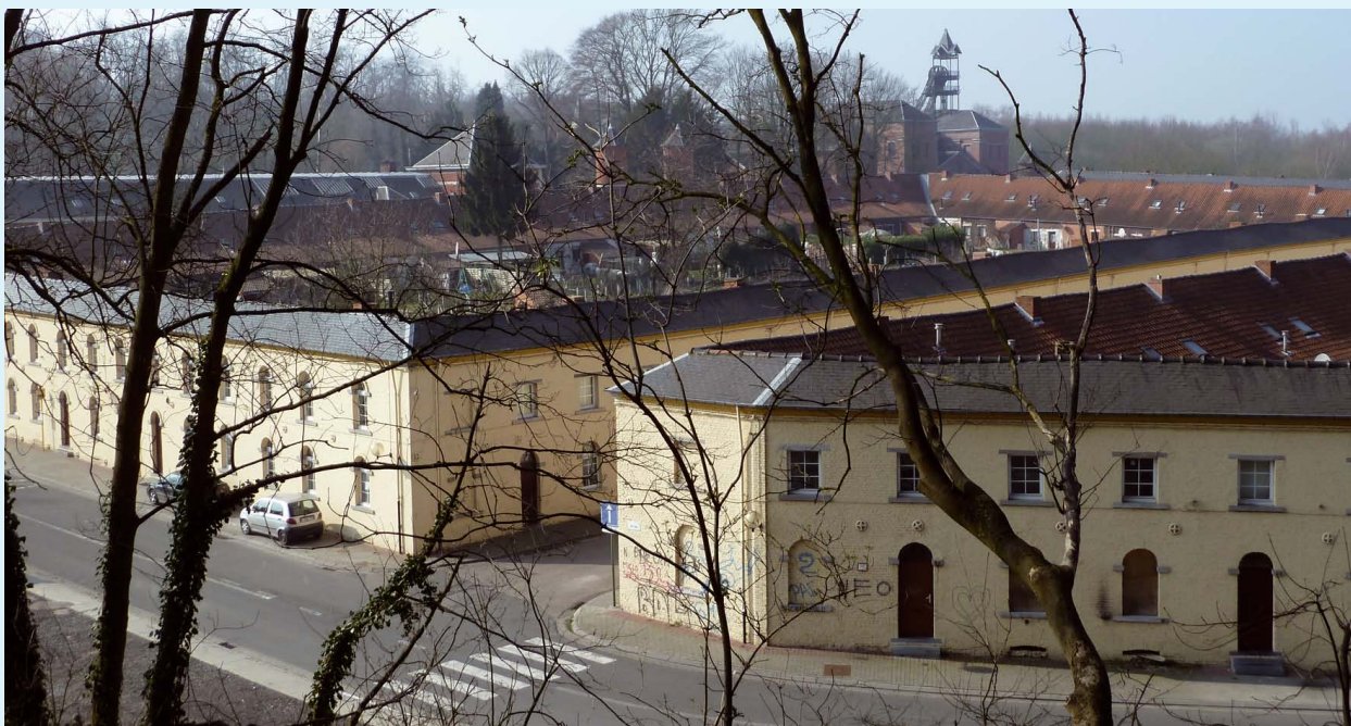
A Bois-du-Luc, aux 166 logements organisés en carrés s'ajoutent une école, des magasins et un établissement hospitalier.
