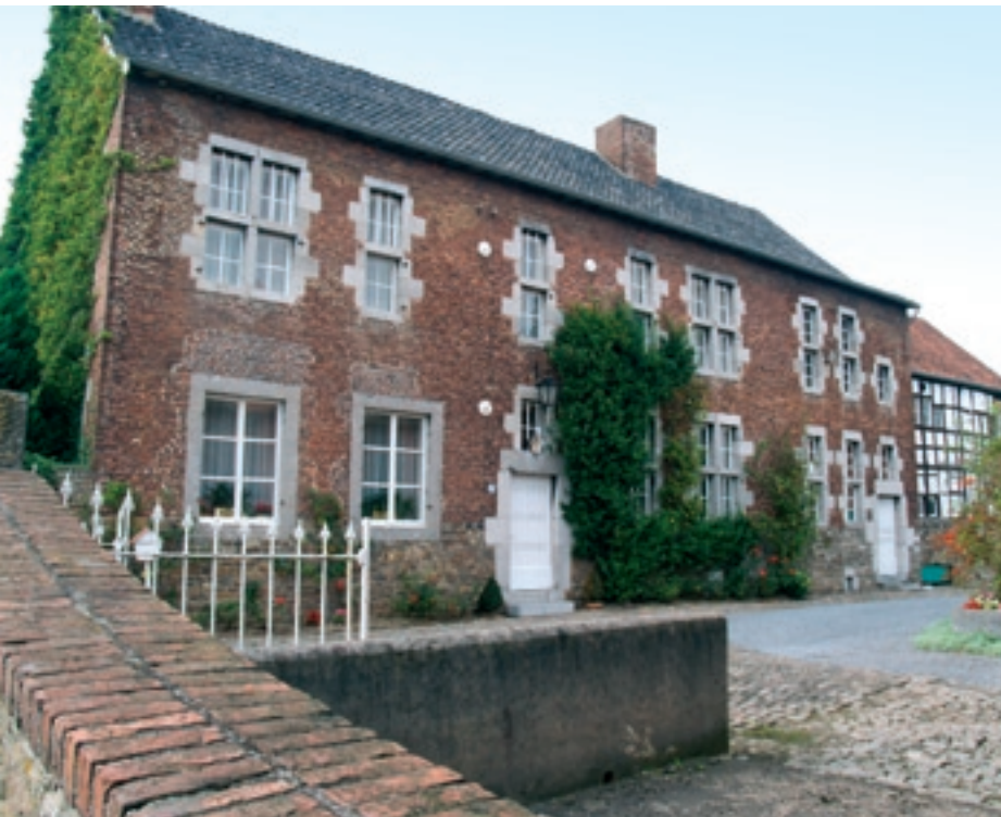
Das bauliche Kulturerbe besteht vor allem aus vielen alten, in der Heckenlandschaft verstreuten Bauernhöfen; der Hof von Langstraat steht unter Denkmalschutz.
