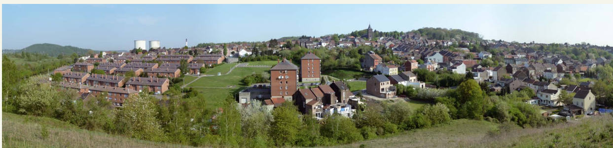
A Marchienne-Docherie (Charleroi), de petites maisons ouvrières accolées, de gabarit identique, s'étagent sur le versant de la vallée du Piéton, au sommet duquel apparaît le clocher de l'ancien village. Elles composent l'essentiel du tissu urbain d'avant la Première Guerre mondiale, en périphérie duquel s'est implanté au cours des années 1950 la cité des Cerisiers, dont les immeubles s'ordonnent rigoureusement.
