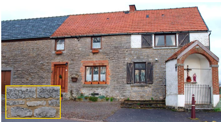
Certaines habitations sont construites en pierre calcaire, mais la pierre locale est d'assez mauvaise qualité et s'abîme sous l'action du gel (Marchevelette).
