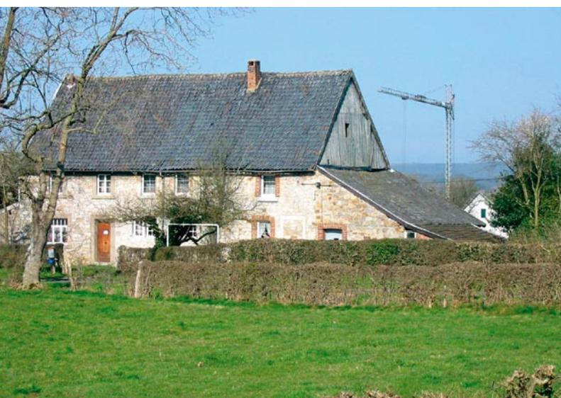
Le bâti traditionnel est le plus souvent en pierres, moellons de grès et de calcaire. Ici, un bardage en bois protège l'un des pignons.
