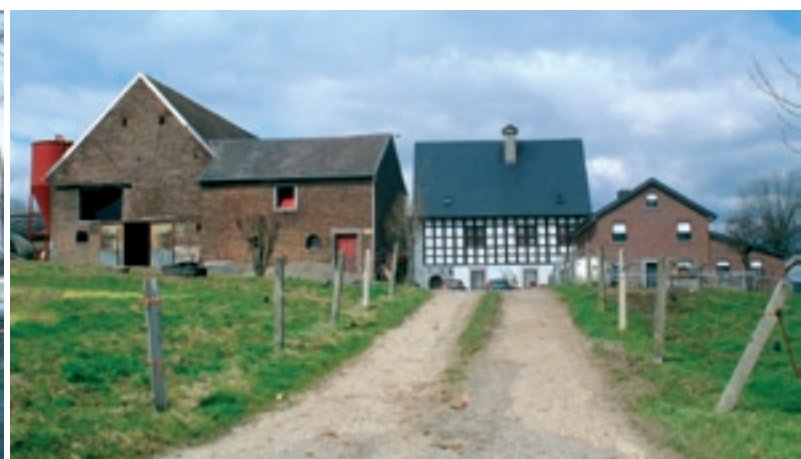
Fachwerkgebäude zeugen von einer Bauweise, die älter ist als Stein und Backsteinbauten; sie sind in dem Gebiet besonders zahlreich. Ein Grund dafür ist das in dieser Region in größeren Mengen verfügbare Holz.
