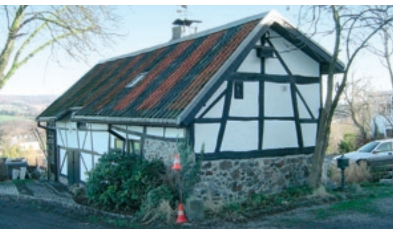
Fachwerkgebäude zeugen von einer Bauweise, die älter ist als Stein und Backsteinbauten; sie sind in dem Gebiet besonders zahlreich. Ein Grund dafür ist das in dieser Region in größeren Mengen verfügbare Holz.
