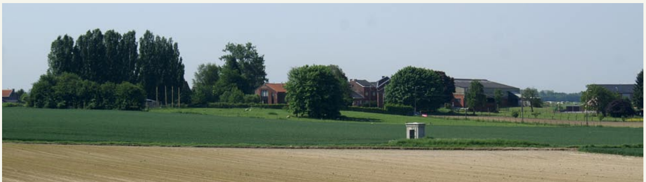
Les paysages portent des traces de l'activité de captage des eaux du sous-sol. Sur le plateau crayeux, de petits édifices, à première vue incongrus et régulièrement espacés, ponctuent certains champs : il s'agit de chambres de visite pour le contrôle des galeries de collecte des eaux. Le captage proprement dit s'effectue, quant à lui, aux points d'émergence de ces eaux, dans les vallées (Hognoul).
