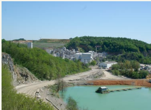
La carrière de calcaire située dans la partie aval de la vallée de la Meuse est peu perceptible depuis la route qui parcourt la vallée, malgré ses dimensions. A gauche, les structures d'exploitation et un vaste bassin de décantation. A droite, un ancien bassin, tout proche, a bénéficié d'opérations de réaménagement, conformément à la législation en ce domaine. Partiellement remblayé et planté, le site actuel profite à la biodiversité.
