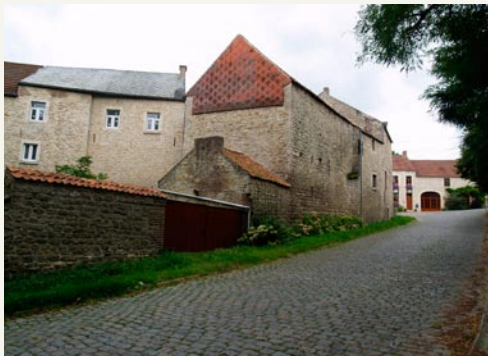
Près de Jodoigne (ici, Saint-Rémy-Geest), des villages sont construits en pierre locale d'âge tertiaire et de couleur très claire, la pierre de Gobertange, un calcaire gréseux. Cette pierre a été exportée de longue date et utilisée dans des bâtiments de prestige comme l'hôtel de ville de Bruxelles.
