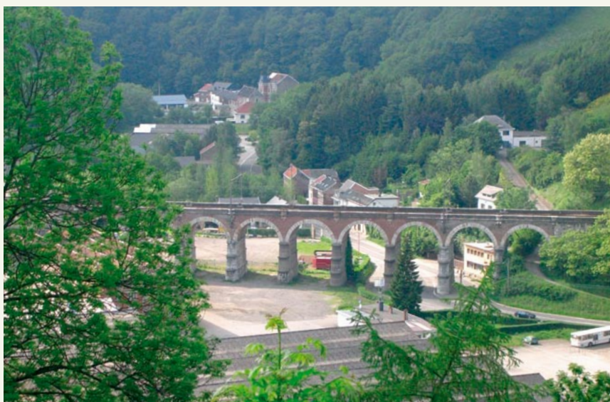
La ligne n° 37 constitue un ouvrage ferroviaire remarquable par ses tunnels, ponts et autres viaducs qui franchissent les méandres de la Vesdre. Ici, elle croise la N61 au pied de Limbourg à Dolhain.
